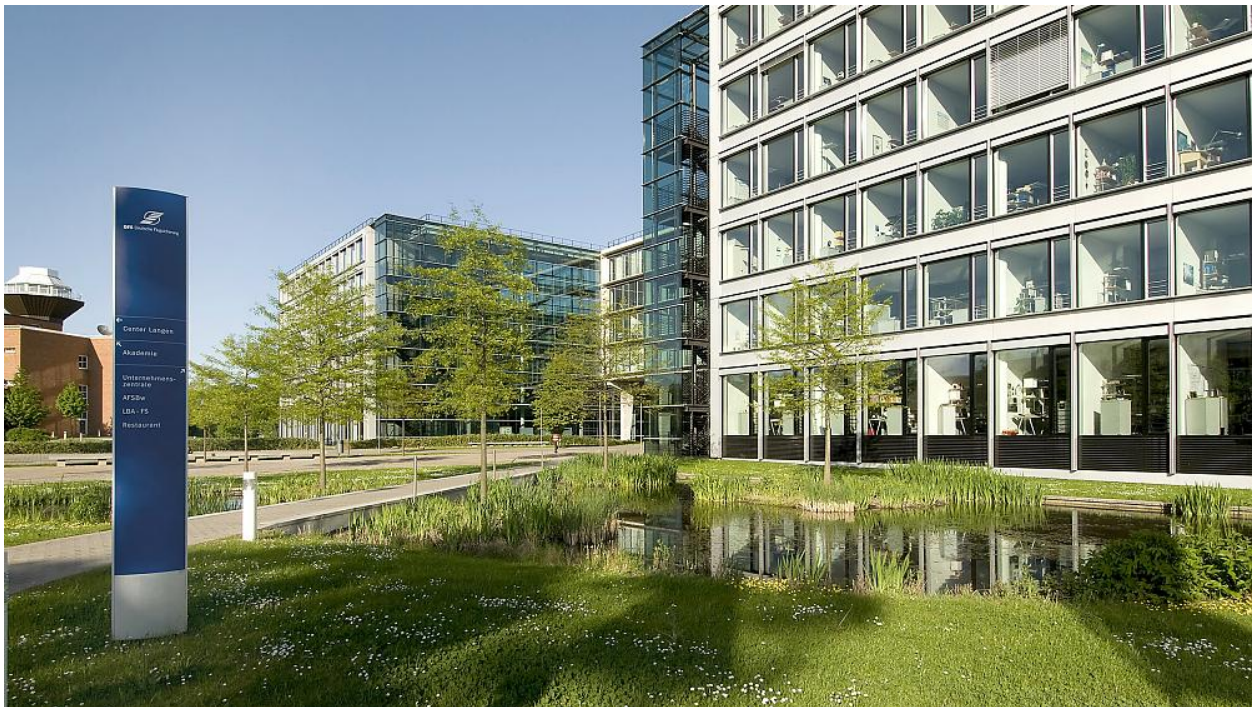
Die Unternehmenszentrale der DFS liegt in Langen, unweit des Frankfurter Flughafens (Quelle: DFS Deutsche Flugsicherung GmbH)
